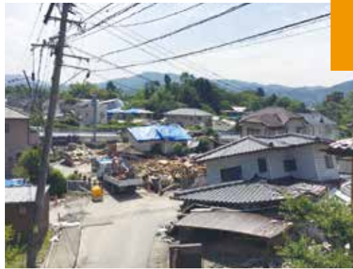
熊本地震での家屋の崩壊 (益城町、6月3日堀内市議撮影)
